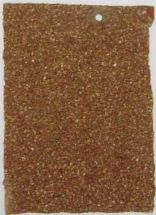
施工9年後の カットサンプル
